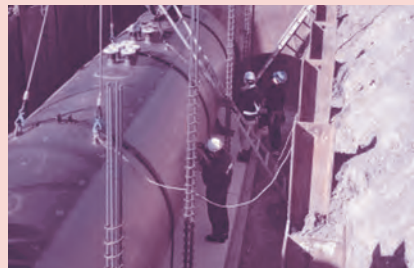
ガソリン等を入れる地下タンクは、埋設前に傷の有無や設置状況について、中間検査を行います(左写真)
